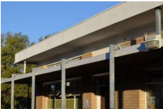
Buitekant van klasse oorgeverf
